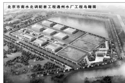
北京市南水北调配套工程通州水厂工程鸟瞰图 通州水厂采用预处理、常规处理及臭氧活性炭深度处理工艺,生产出的自来水完全能够
