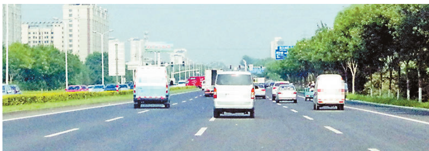
顺平路南半幅已改为4条车道
