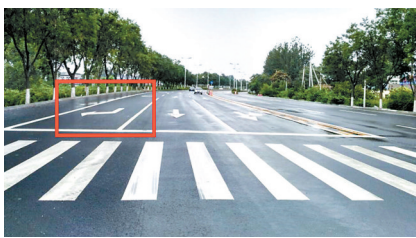
通顺路与李天路路口现状
