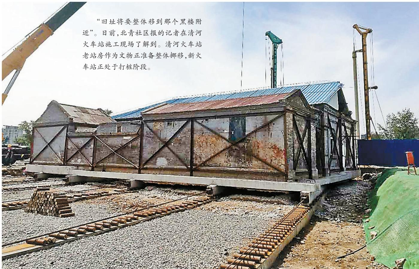
“旧址将要整体移到那个黑楼附近”。日前,北青社区报的记者在清河火车站施工现场了解到。清河火车站老站房作为文物正准备整体挪移,新火车站正处于打桩阶段。
