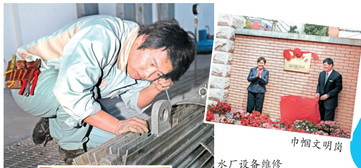
水厂设备维修
