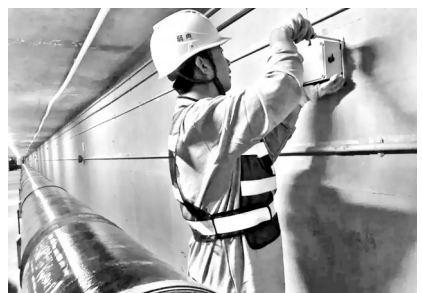
城市大脑中关村西区地下动力管廊里,工作人员正在安装监测有害气体的传感器
