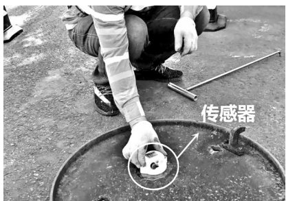
海淀西街和海淀大街十字路口,工作人员在井盖下安装物联网传感器,监测井盖位移
