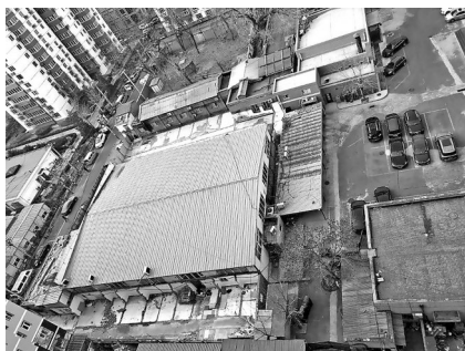
违建拆除整治前
