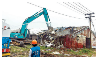
拆除违建建设
