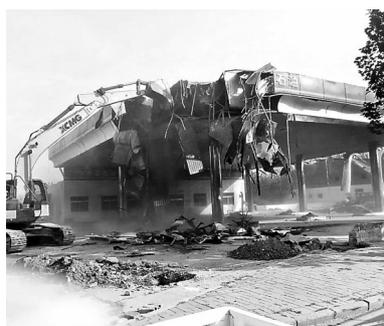
挖掘机同时工作,对加油站的主体建筑和门面房进行拆除,消防车同时进行降尘工作。
