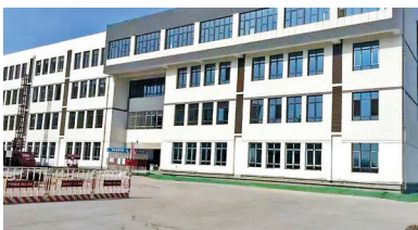
项目主体结构已完工
