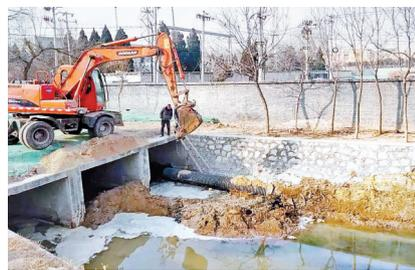
临空经济核心区管委会、市政控股等多部门共同研讨，最终决定实施二线沟截污纳管工程，沿二线沟西岸新建1.9公里污水管线，采用暗涵的方式，直接排入七干尾污水处理
