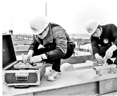
工人正在检查测量设备
