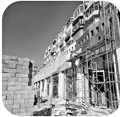
定福庄北街改造前
