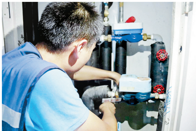
工作人员为居民更换新表
