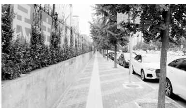
南部社区:北花园街道路铺装完成
