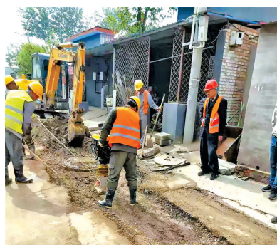
进行污水管道的铺设
