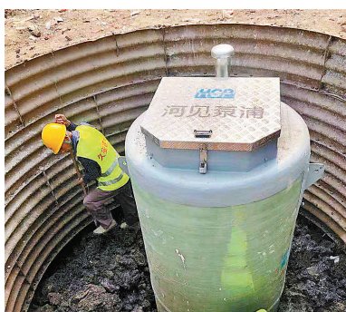
西陈各庄提升泵回填
