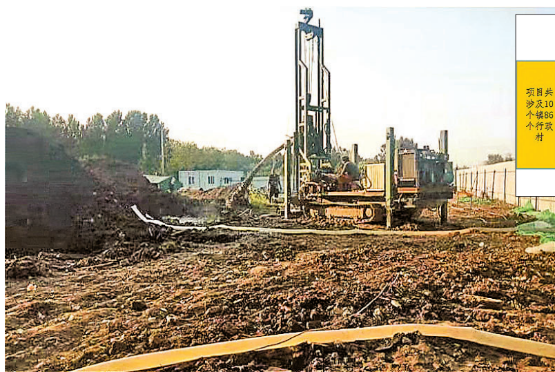
西小管厂站打井降水
