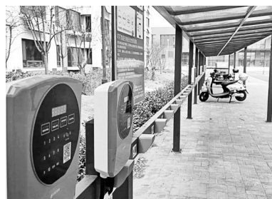
在用电安全方面,充电桩设有多重保护程序,一旦发生短路,将立即断电,保证
