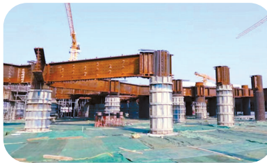
承担未来楼层建设重量和稳定的承重柱
